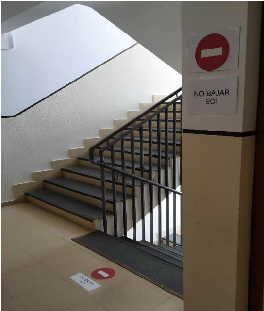
Fig. 3: Escalera central de subida.
